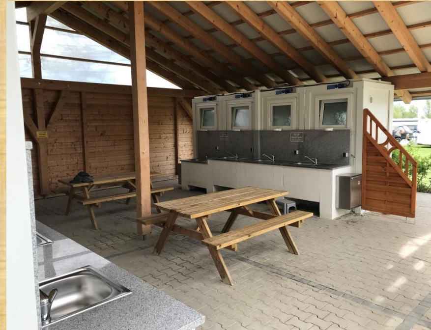
Spülküche; mit Chip-System
